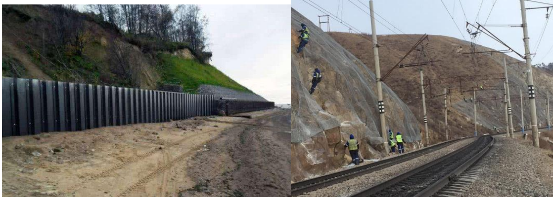
Рис. 5. Защитные устройства от оползневых явлений
